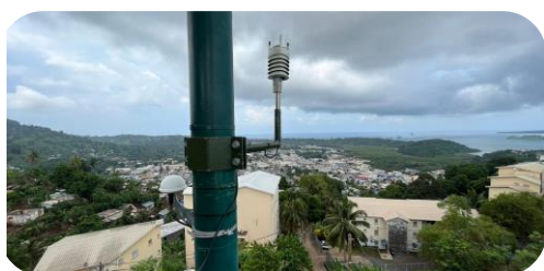
Figure 4 : Station météo installée sur le pylône TDF de Convalence
